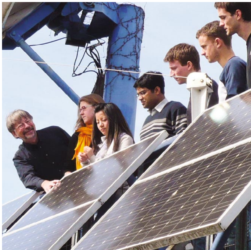
Prof. Georg Scharfenberg (li.) mit Teilnehmern bei der Besichtigung der Flachdachanlage der Hochschule Regensburg
